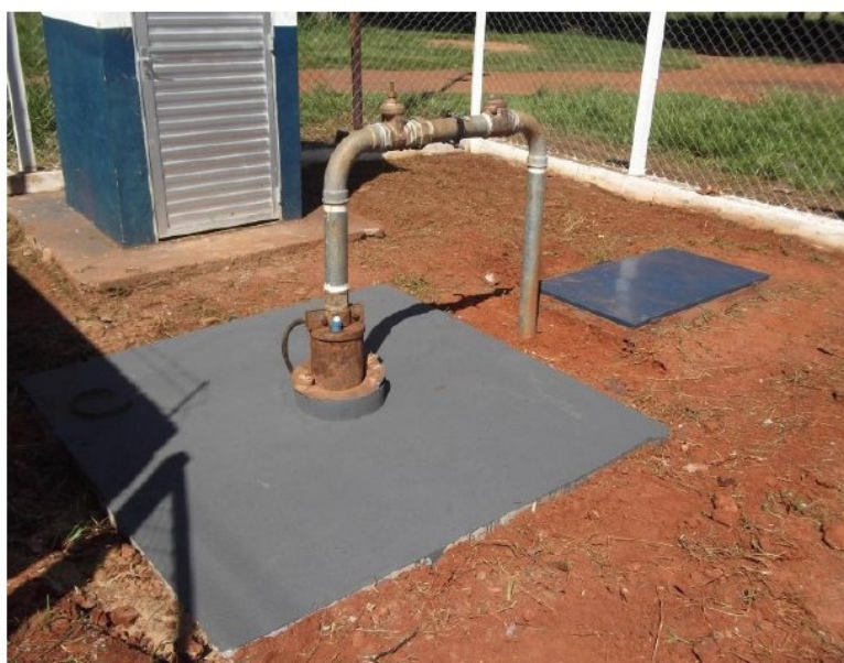
FOTO 3. Laje de proteção para poço artesiano.
